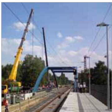
Gleisverlegung auf der neuen Brücke über den Flakenfließ Foto: Kober
