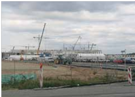
Tesla-Baustelle am 24. 9. 2020, Fotos: E. Strauß
